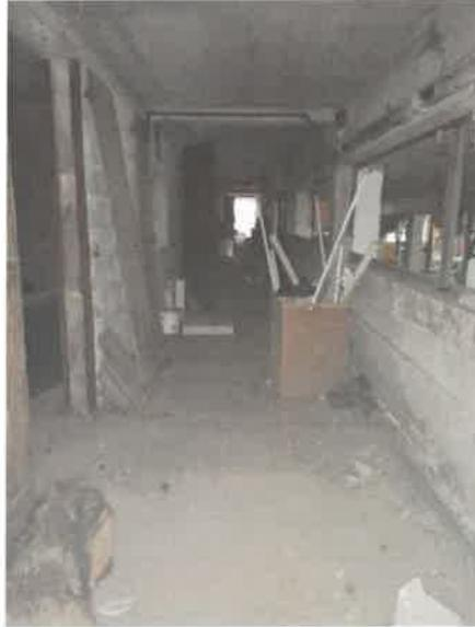
Les 6 pièces aveugles du niveau supérieur. Elles comprennent de vieilles portes en bois sur cadre métallique, l'ensemble hors d'usage. La 2<sup>ème</sup> pièce est doublée de panneaux isolants phoniques.
