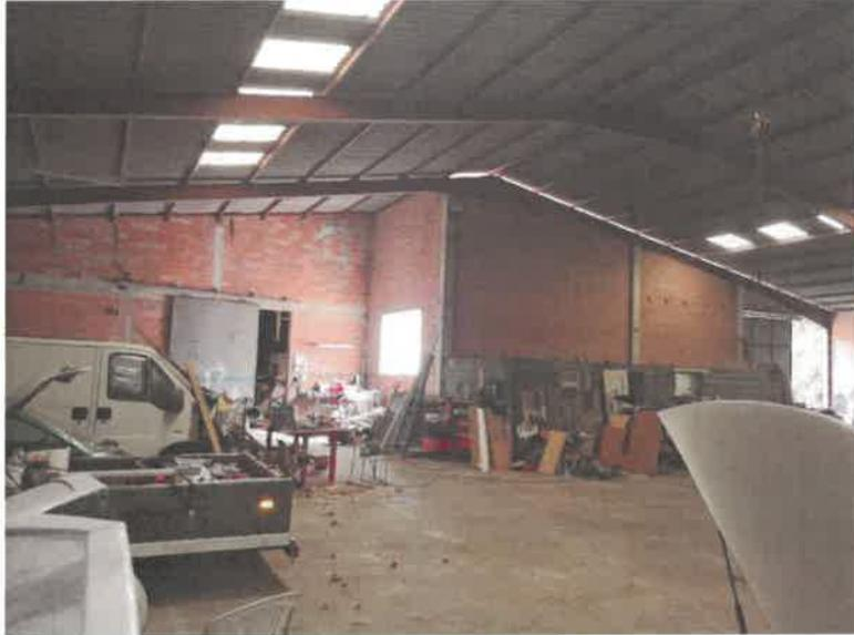
Au Sud, une construction sur le flanc, desservie par un portail coulissant métallique, couvert de tôles fibro ciment dégradées sur charpente métallique à deux pans
